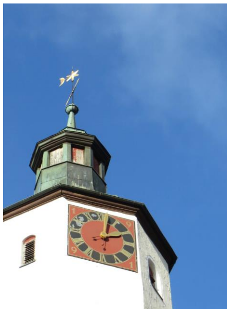
Abbildung 6 Kirchturm St. Cyriakus
